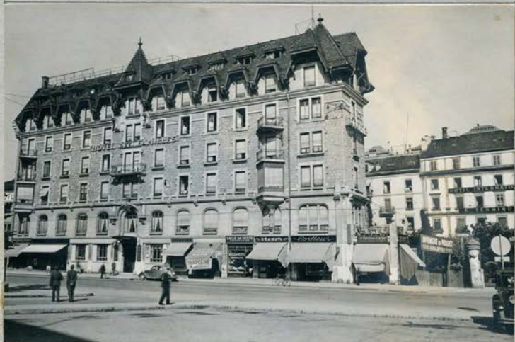
PHOTO NR 1 FAÇADE NORD-OUEST
