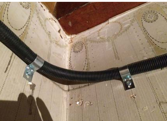
Grand Hôtel des Rasses travaux d'assainissement découverte papier peint
