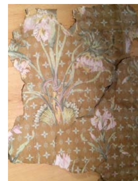
Hotel Nest und Bietschhorn Blatten Wandtapeten nach Umbau
