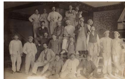
Ouvriers à la fin des travaux en 1913 archives du Grand Hôtel des Rasses
