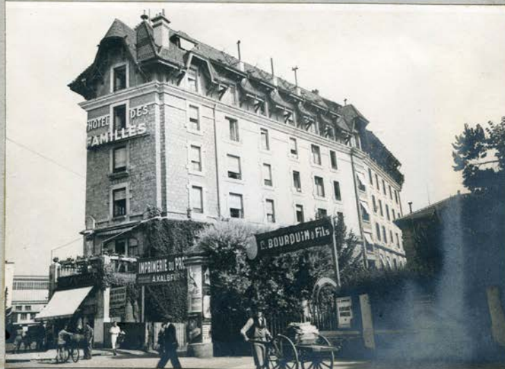
PHOTO NR 2 FAÇADE SUD-EST.
